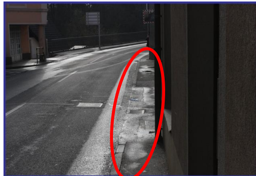
Nevarni pločniki na državni cesti
